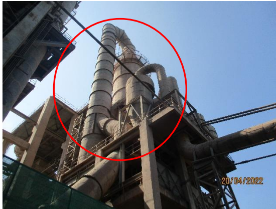
รูปที่ 7 Preheater Tower
