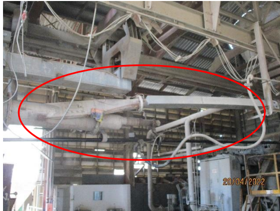
รูปที่ 3 ระบบป้องกันผงบดแบบอัตโนมัติ
