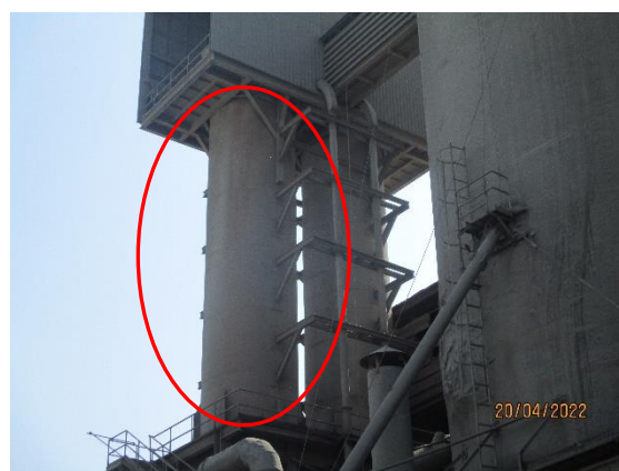
รูปที่ 25 ไซโลสำหรับเก็บแฉะลอย
